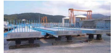
プレキャストPC床版の養生(敦賀工場)
