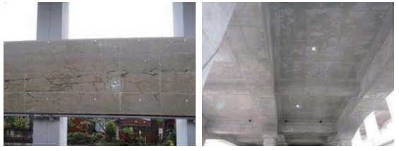
背景：上越新幹線のASR劣化(阿賀野川産骨材のASR対策)
