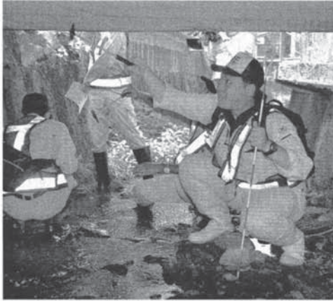
橋の下に入り、ハンマーでたたいて点検をするメンテナンスエキスパート(10日、見附市で)
