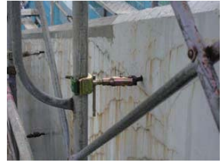
鉄道橋・PC橋梁に建設後数年で発生したASR事例(宮城県)
