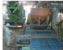
フライアッシュコンクリートの打設
