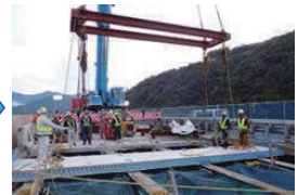
プレキャストPC床版の設置
