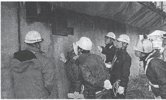
下部工補修の状況を観察する参加者
