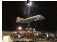
旧RC床版の撤去
