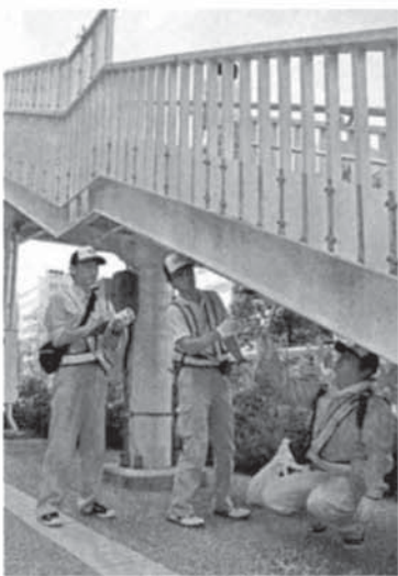
歩道橋の状況を点検するME 新潟の会のメンバー＝7月、 新潟市中央区東大通
